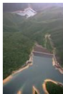
緊急稼働した塩原水力発電所八汐ダム
